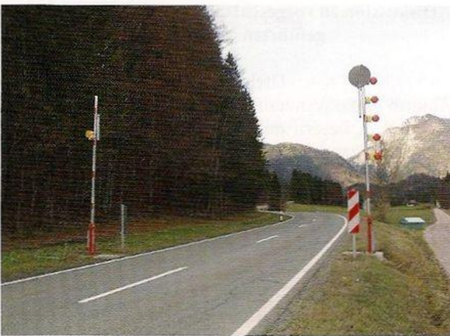
Abb. 10: Als ein Ergebnis des Amphibienschutzprogramms von 2010 wurden zwei Vollschrankenanlagen (diese hier bei Seegatterl) zur Straßensperrung errichtet. / Fig. 10: One initiative of the 2010 amphibian protection programme was the construction of two boom gate systems (shown here is the one at Seegatterl) for completely closing the road.
